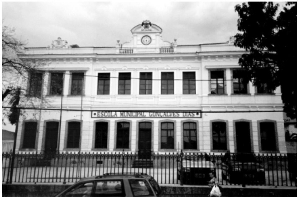
Figura 3 – Fachada frontal da Escola Gonçalves Dias
