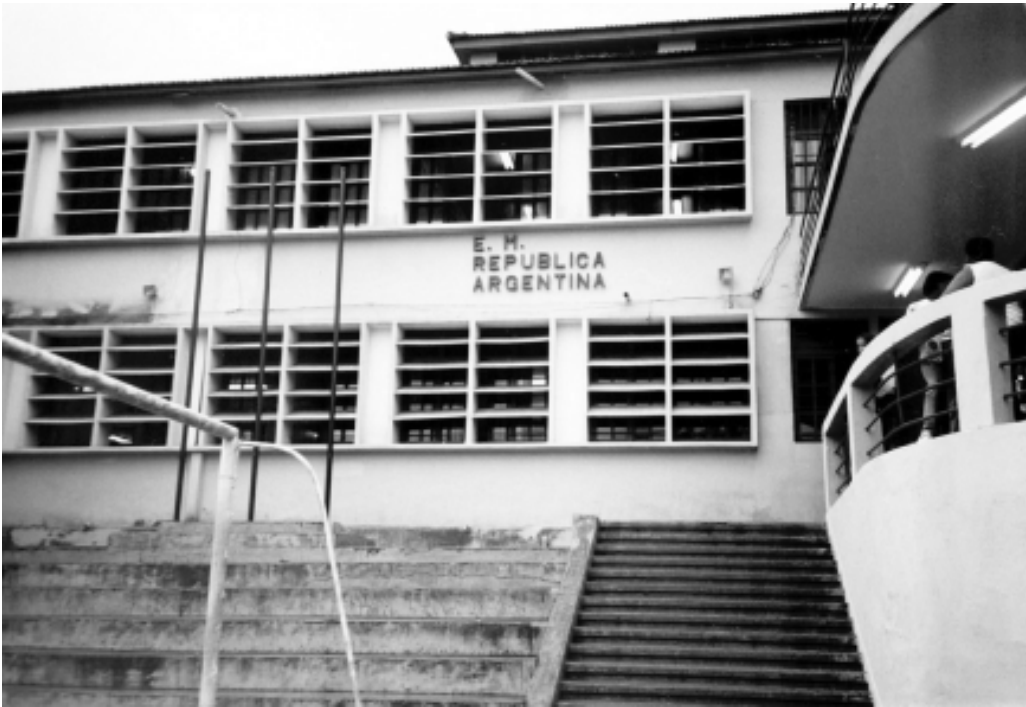
Figura 5 – Escola República Argentina. Fachada vista do pátio frontal
