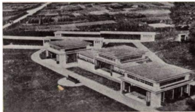
Aspectos de uma moderna construção para jardim de infância nos Estados Unidos. Reproduzidos de Wright and Medwin, "The design of Nursery and Elementary Schools."
